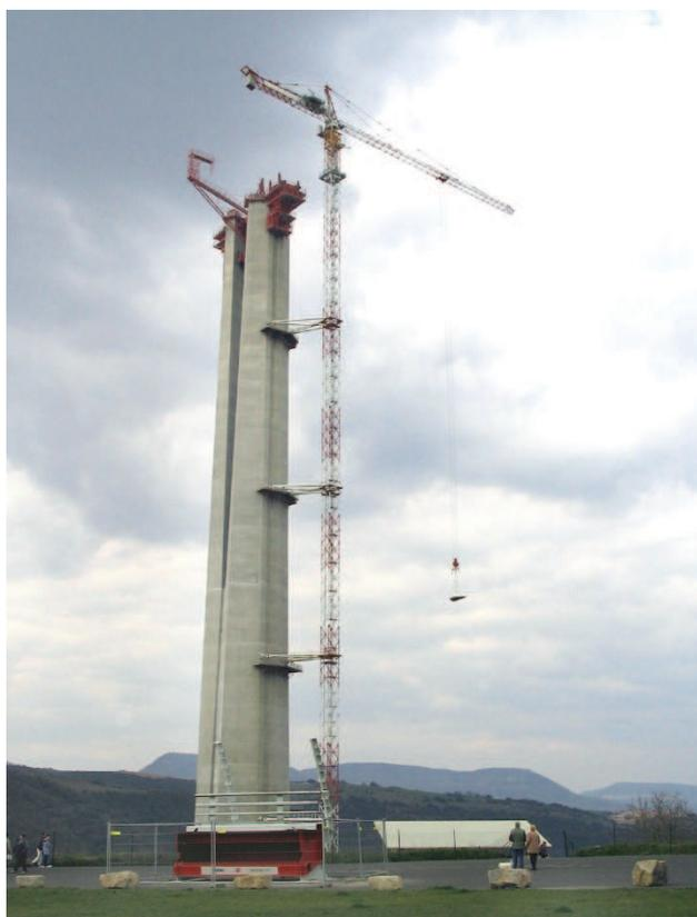
Construction du viaduc de Millau (2003). Hauteur maximale 343m. La plus haute pile du monde, résultat du génie et du travail des hommes.
