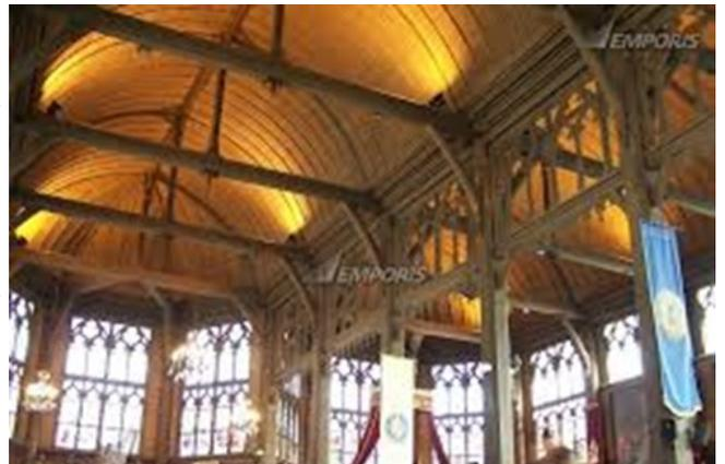
L'assemblage de la charpente se nomme la ferme, sa forme de base est le triangle, formé de deux arbalétriers suivant la pente de la toiture, et d'un entrait qui les relie à leur base.
